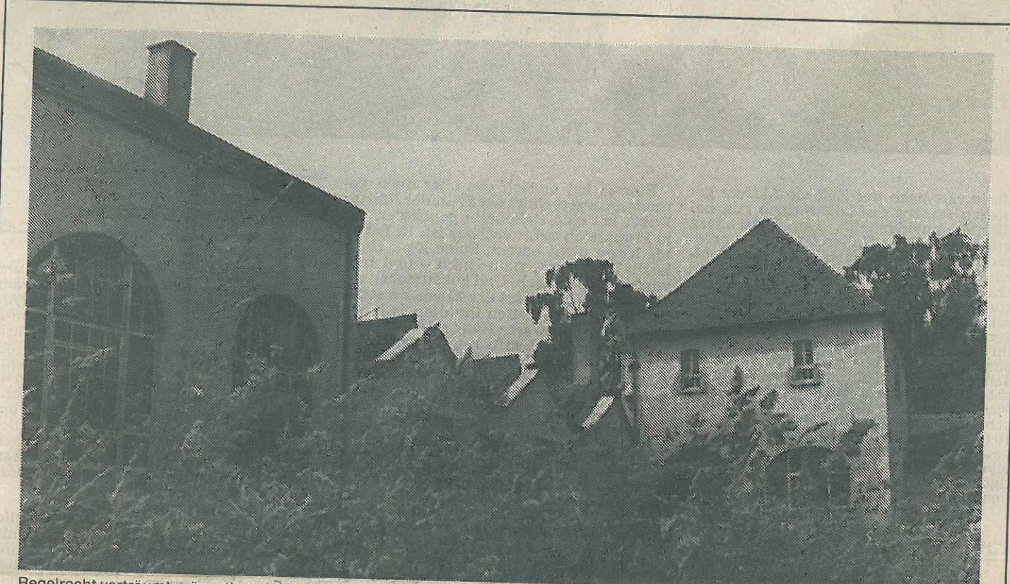
Regelrecht verträumt präsentiert sich heute das frühere Steiger-Werk in Burgrieden, hier das Turbinenhaus. Könnte hier eines Tages einmal ein kleines Steiger-Museum eingerichtet werden? SZ-Foto: Bartels
